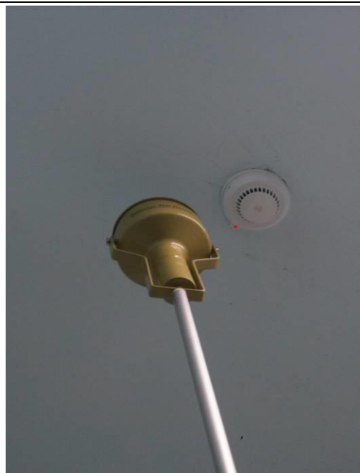
說明：○○探測器動作試驗
