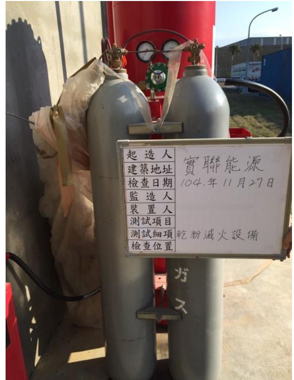
說明：乾粉(二氧化碳)滅火設備鋼瓶啟動裝置(電磁閥、壓力開關)
