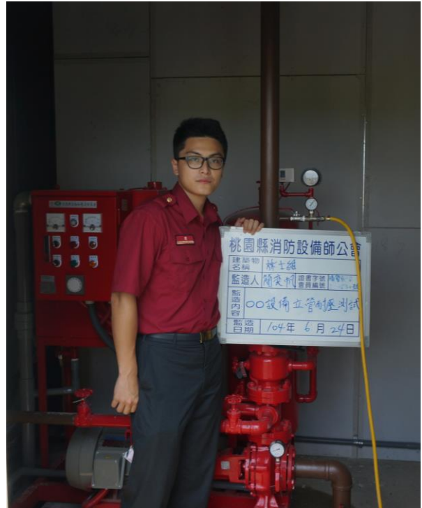
說明：室內消防栓配管試壓(遠景)
