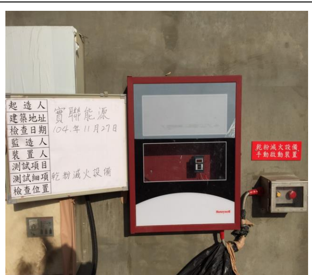
說明：乾粉(二氧化碳)滅火設備鋼瓶啟動裝置(電磁閥、壓力開關)
