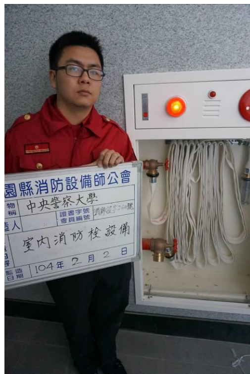
說明：室內(外)消防栓箱開啟
