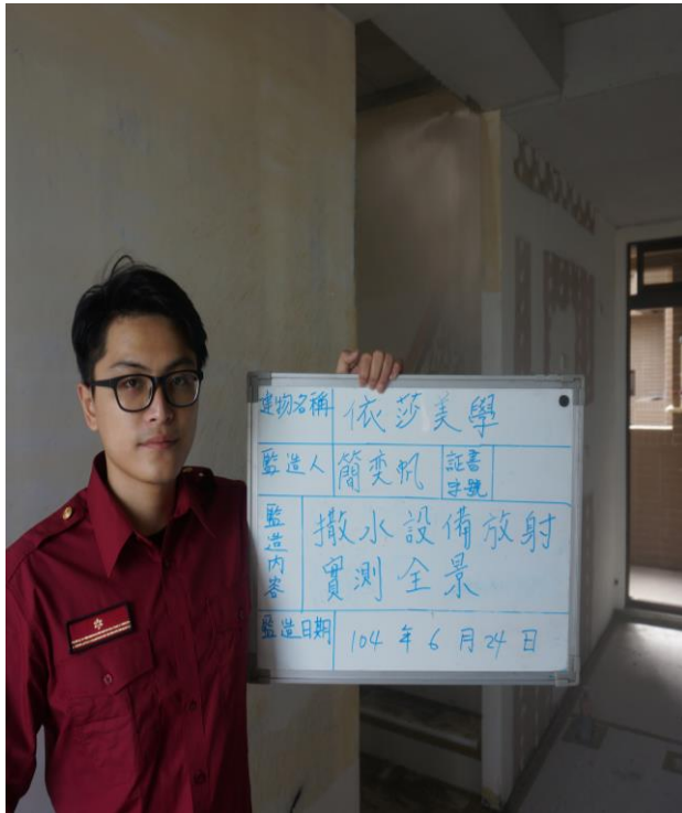
說明：撒水設備放射實測(遠景)
